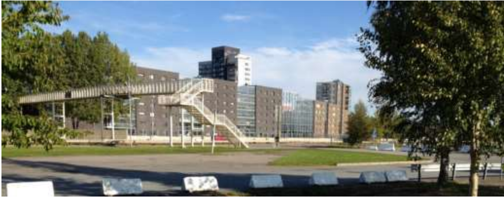
Befintlig gångbro från Frihamnen till Brämaregården över Hamnbanan och Lundbyleden.
