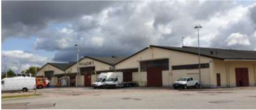
Magasin E inom nordöstra delen av planområdet, sedd västerifrån. (Norconsult)
